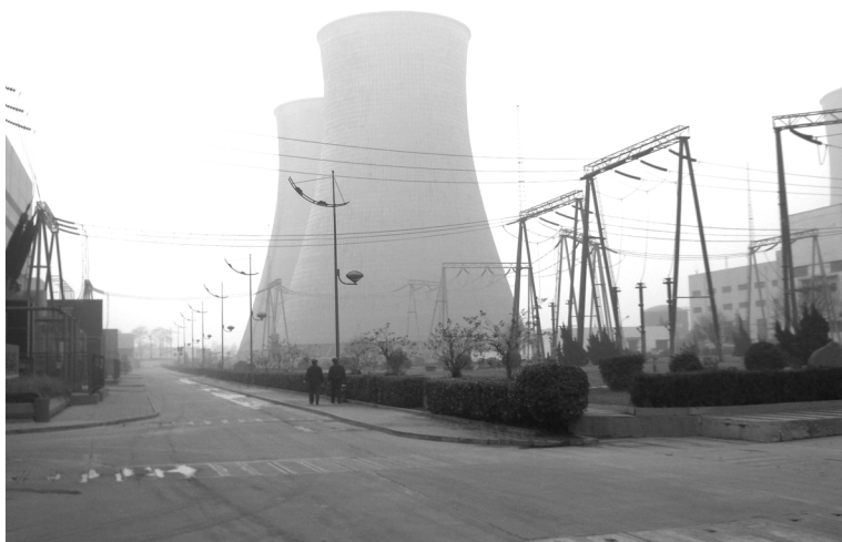
图4.6 发电厂的冷却塔
