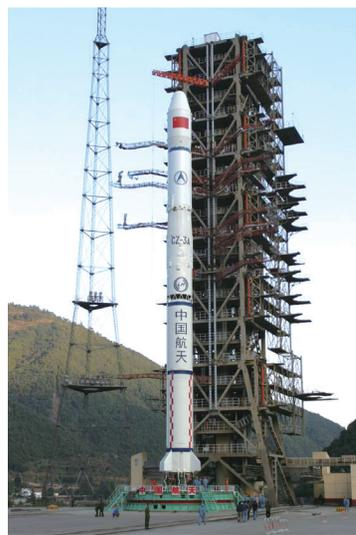
d. 桁架结构的卫星发射塔
