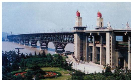
b. 桁架结构的桥梁
